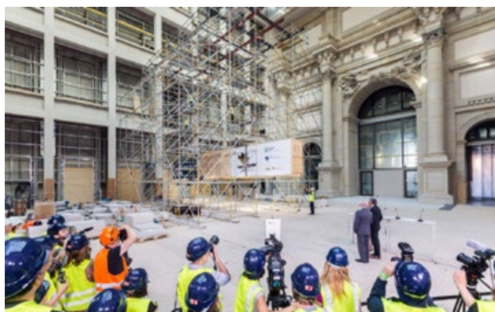
Im Foyer wird die Kiste mit einer Spezialvorrichtung auf Höhe des 1. Obergeschosses gehoben.
