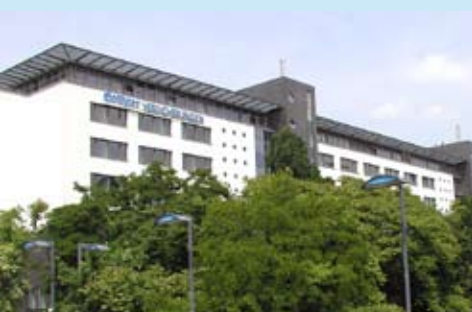
10 Gothaer Schaden-Service-Center in Berlin-Tempelhof am Teltowkanal
