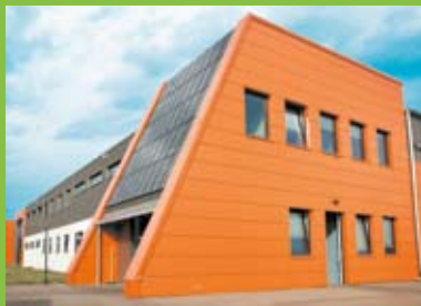
Solaranlage Johanna Solar
